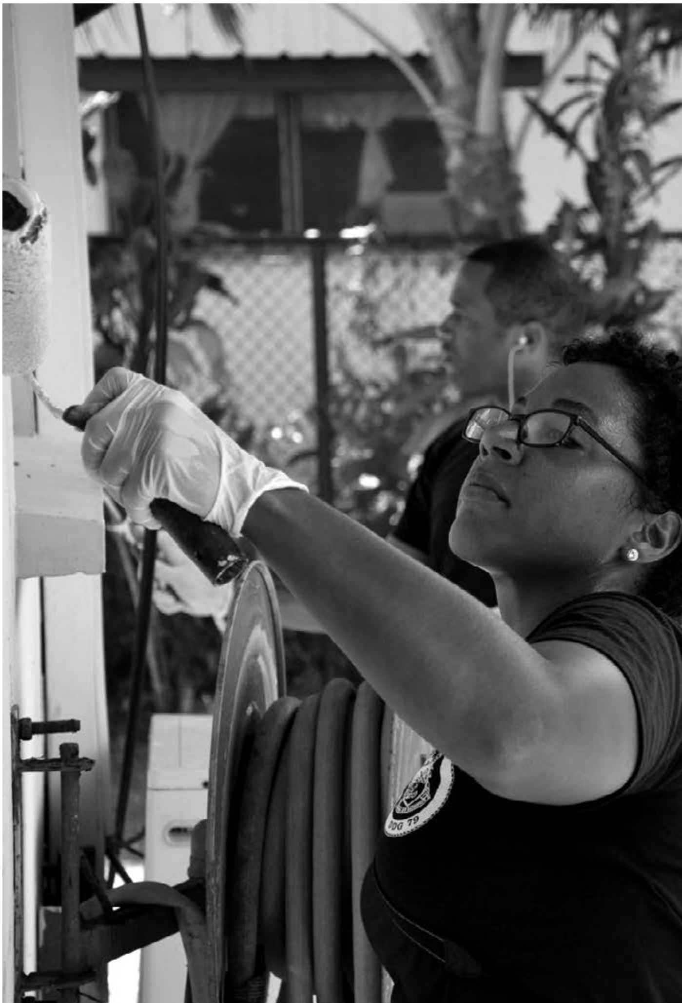
Voluntarista en un programa de construcció i restauració d'infraestructures. Font: Commander, US, sota llicència de creative commons.
