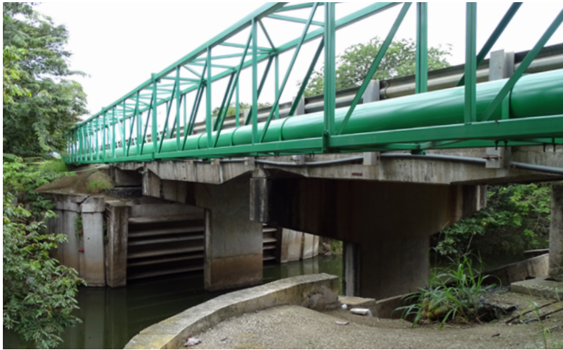
Canonada de l'aqüeducte de Nimboyores, setembre 2018.
